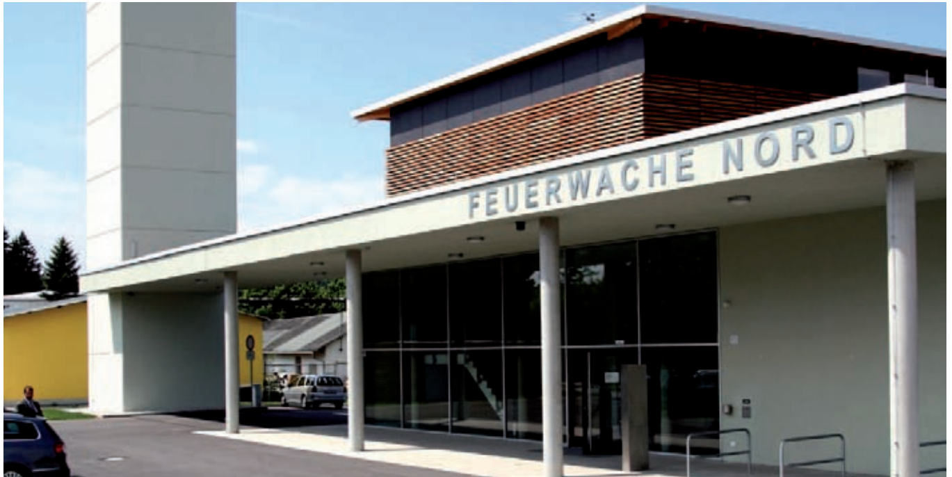
Das Gebäude der Feuerwache Nord: Bei Einsatzalarm schaltet KNX die Beleuchtung der Verkehrswege ein.
