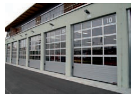
Je nach Einsatzszenarie öffnen sich entsprechende Tore für die Einsatzfahrzeuge. KNX schaltet die Beleuchtung der Verkehrswege ein.
