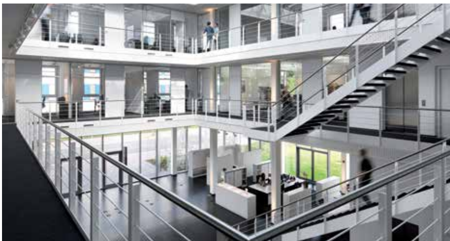
Luftig und transparent: Der Neubau von DIAL in Lüdenscheid.
